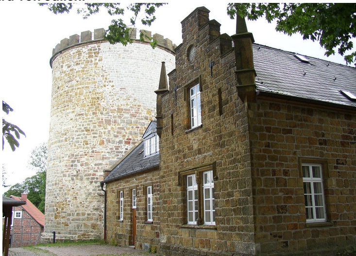
Ravensburg Wehrturm und Forsthaus
